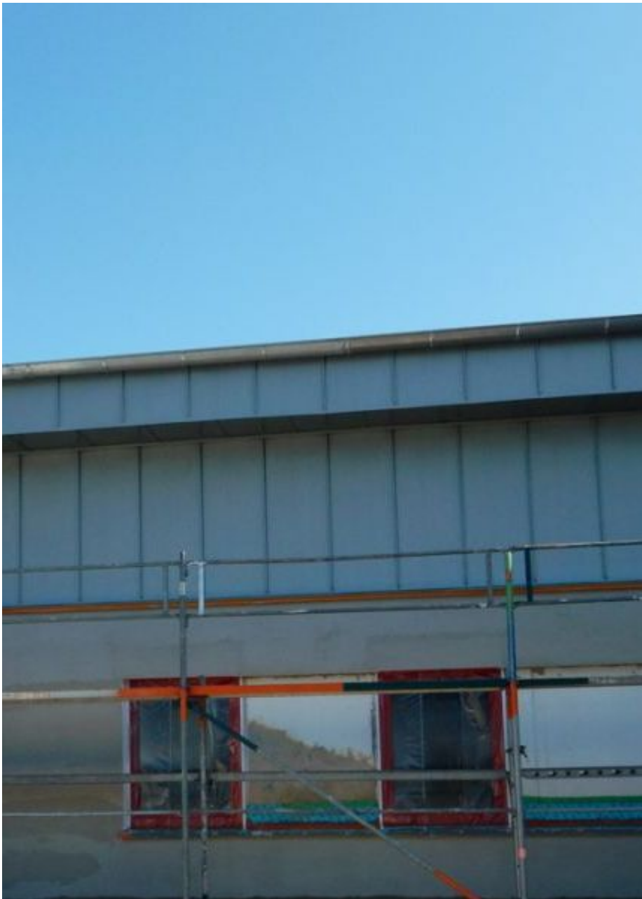
Zink Winkelfalz als Dachrandabschluss
