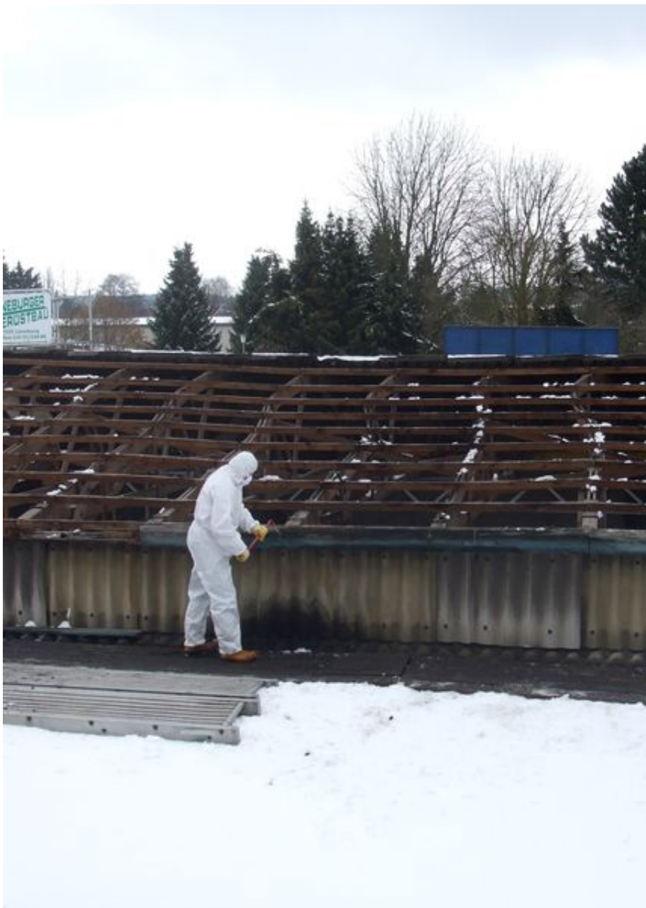
Asbest, Abriss & Entsorgung
