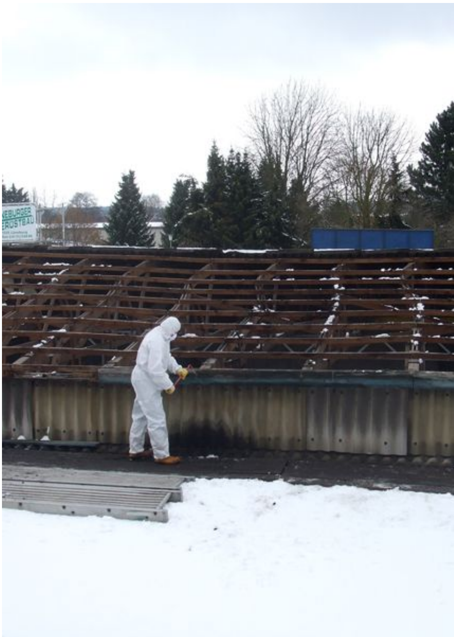
Asbest, Abriss & Entsorgung
