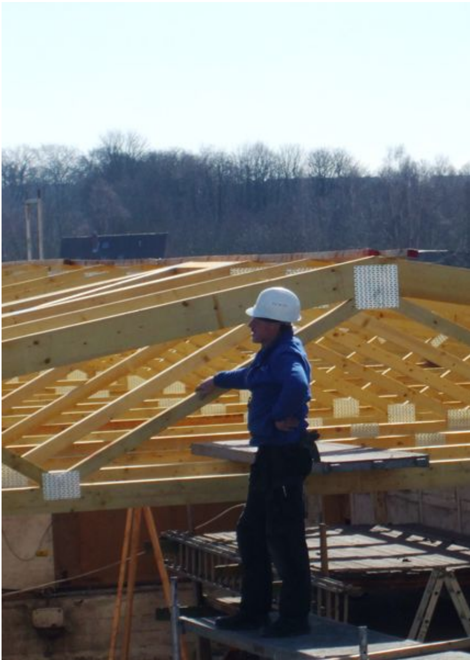
Stellen eines Dachstuhl
